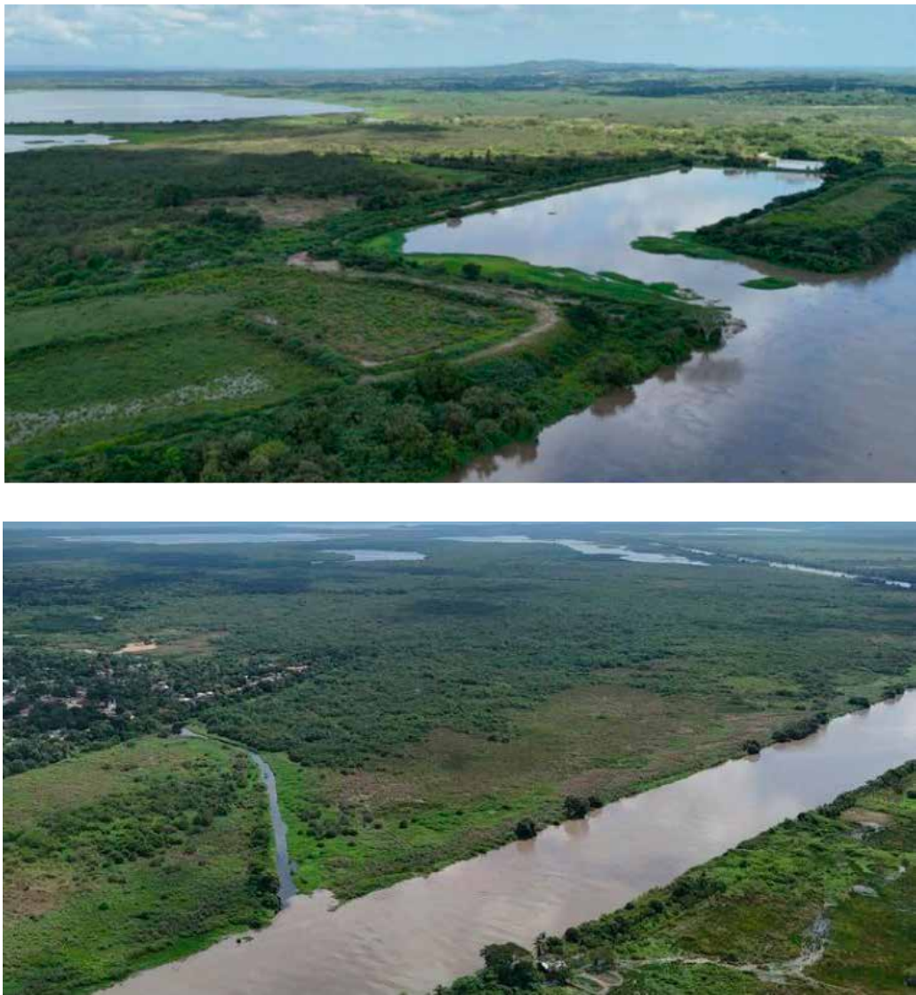
Figura 6: Canal del Dique en Sector Puerto Badel y Dársena de Juan Gómez. Nótese la incidencia del ángulo de conexión en la inhibición del caudal sólido (sedimentos) que lleva el cuerpo léntico principal al secundario Fuente: (Escobar, 2026)
